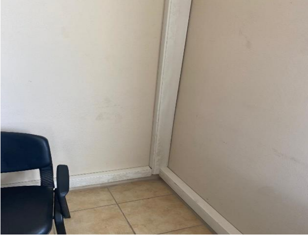
Kullanıcı Birimlerdeki kullanıcı sayılarının artması ile ilgili noktalara ilave network kabloları çekilmiştir
