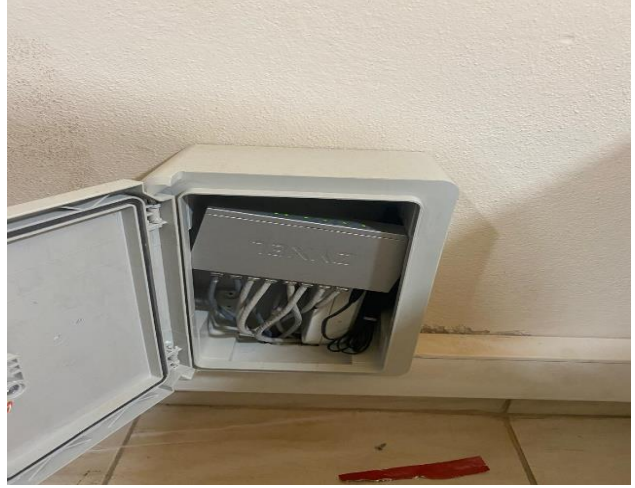
Sistem odası, santral kabini bakım ve onarımları gerçekleştirilmiştir.
