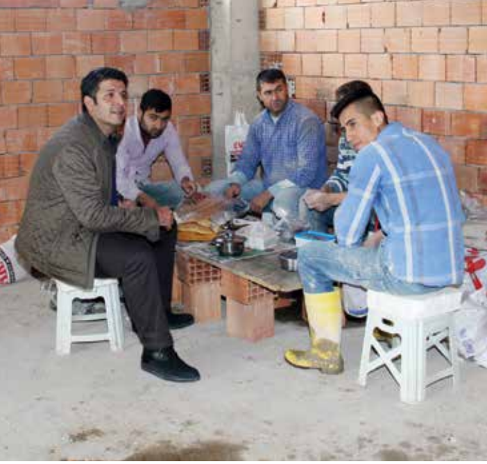
Parke Tesisleri ile Ahşap ve Demir Atölyeleri inşaatını gezen Başkan Genç, şantiye alanında işçilerin sofrasına da konuk oldu.
